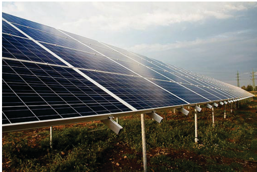
Фиг. 1. Едноскатен монтаж на ФВ панели
