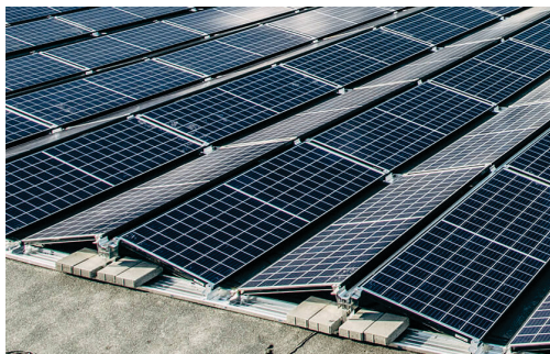
Фиг. 2. Двускатен монтаж на ФВ панели
