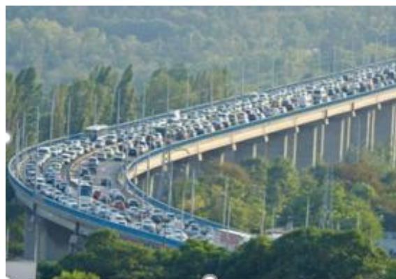
Фиг. 1. Натовареност на Аспарухов мост – Варна – 07.08.2025 г., вследствие на ПТП [28]
